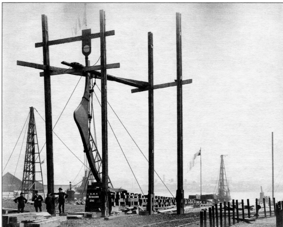
Вверху: киль броненосца «Виктория» с пристыкованным на место форштевнем. Внизу: таранный форштевень броненосца «Санс Парейль»
